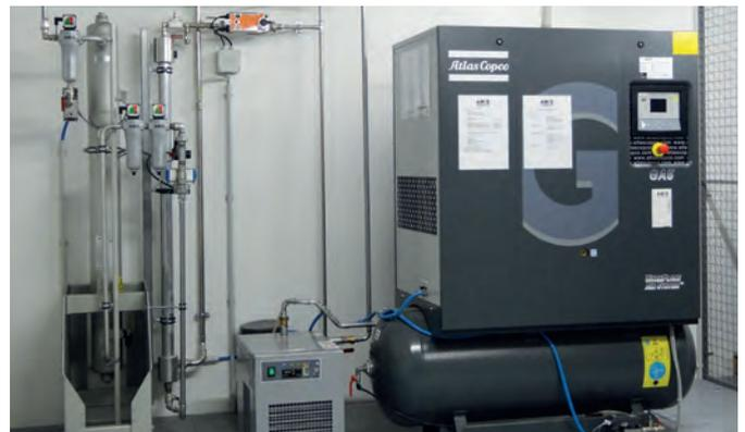
Bild 3: Aus dieser Maschine wird der Stickstoff in die Räume gepumpt, um dort eine sauerstoffreduzierte Atmosphäre zu erzeugen
