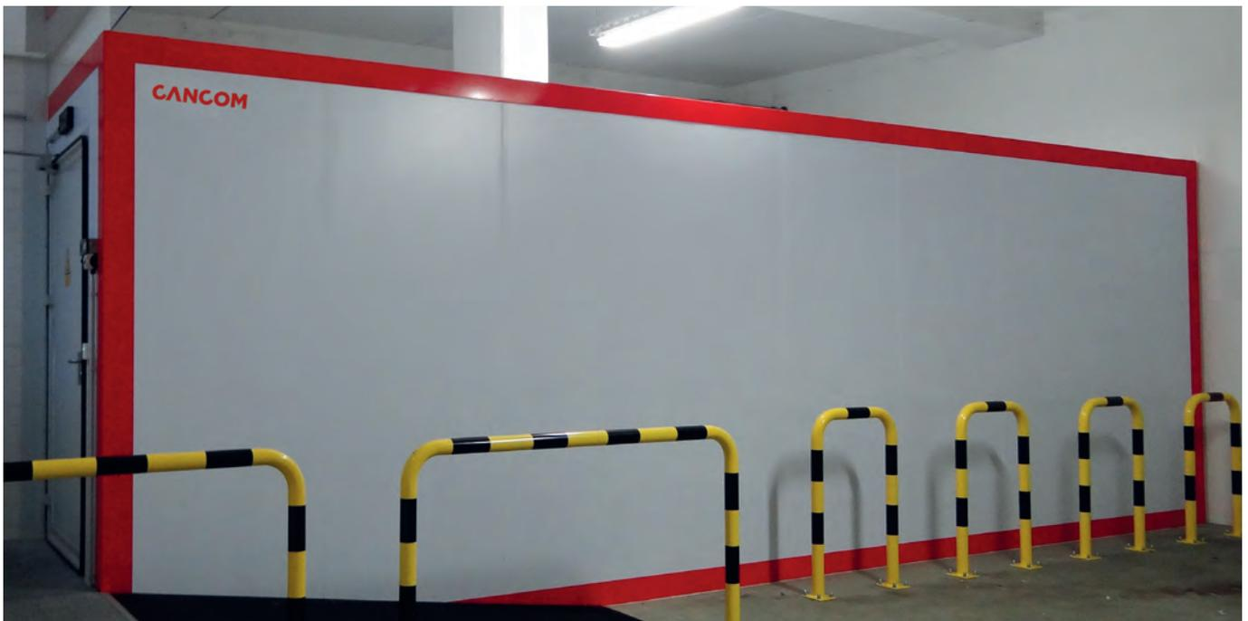
Bild 1: Die EN-1047-2-zertifizierte Sicherheitszelle in der Tiefgarage des Cenit-Gebäudes beherbergt eines der beiden Rechenzentren am Standort
