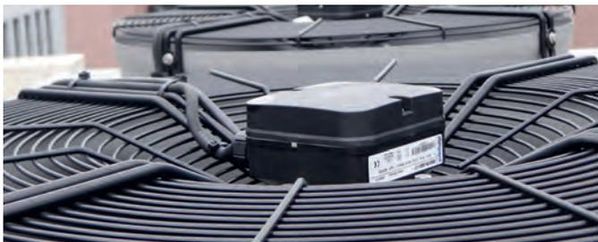
Bild 2: Die Kaltwassersätze kommen im Zuge der intelligenten freien Kühlung nur bei Außentemperaturen über 16°C zum Einsatz.
